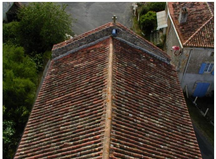
REFECTION COMPLETE DE LA TOITURE – sur 2023
